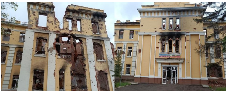
Рис. 1. Фасад будівлі школи № 134.
