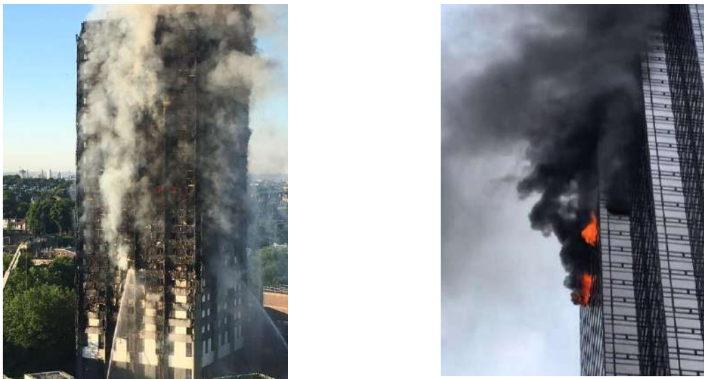
Рис. 2. Наслідки пожеж у висотних будівлях з фасадами світлопрозорих конструкцій.
